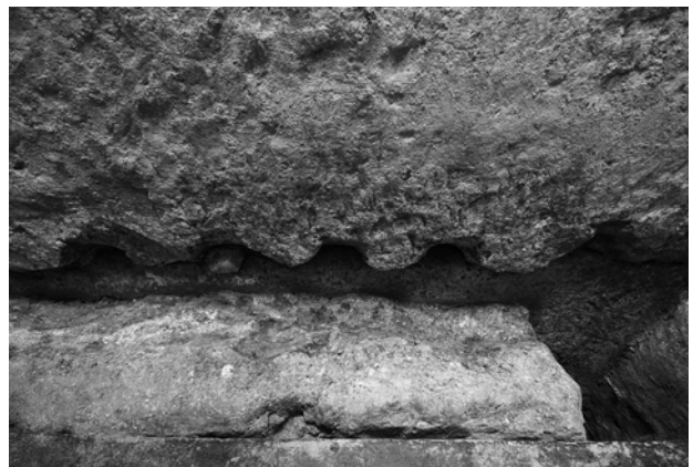
図100 南壁石南面下端の梃子穴
