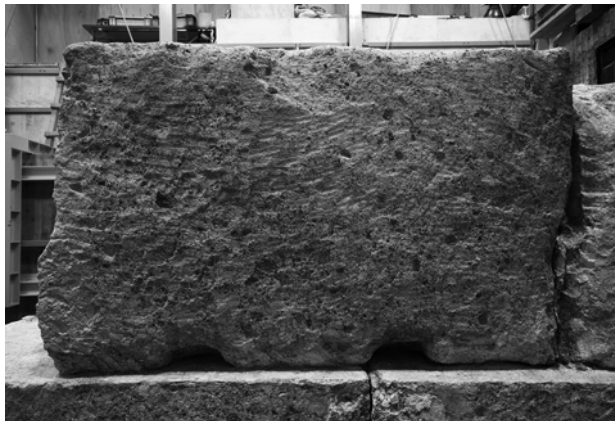
図97 天井石側面の加工痕跡と梃子穴（天井石2西側面）
