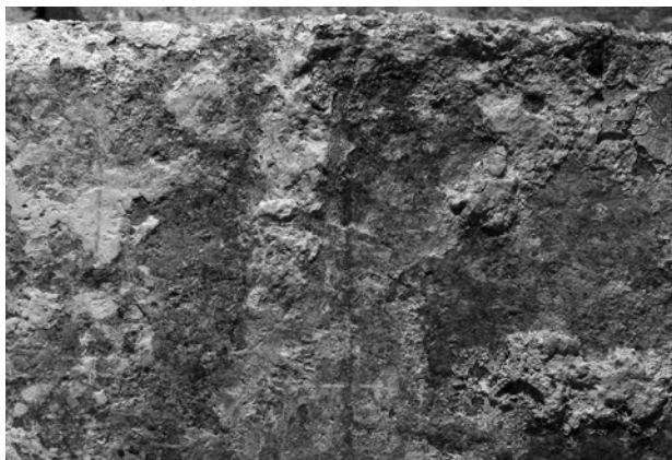
図101 壁石接合面の朱線（東壁石3北小口）
