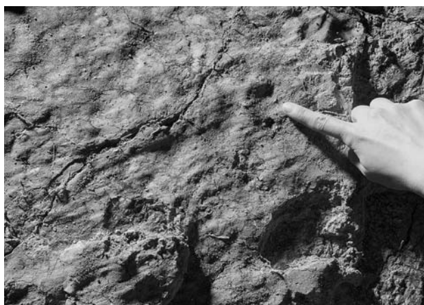
図144 ムシロ痕跡と搗棒痕跡（上位版築下層）
