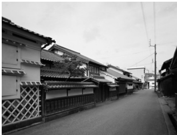
図25 主屋正側面 南西から
