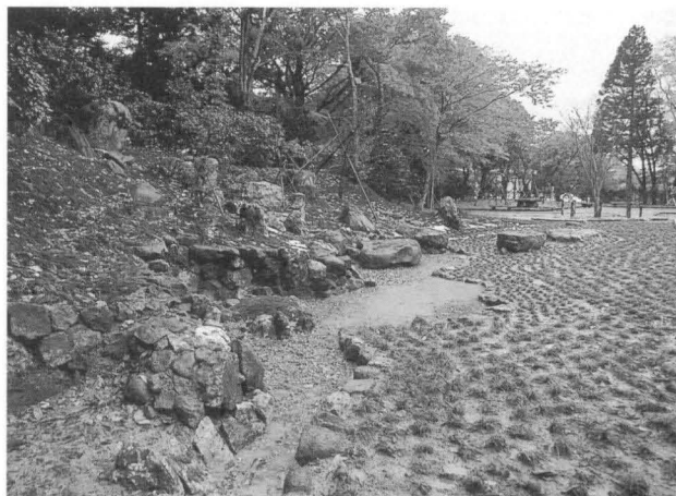
図54 竣工なった庭園全景(東から)
