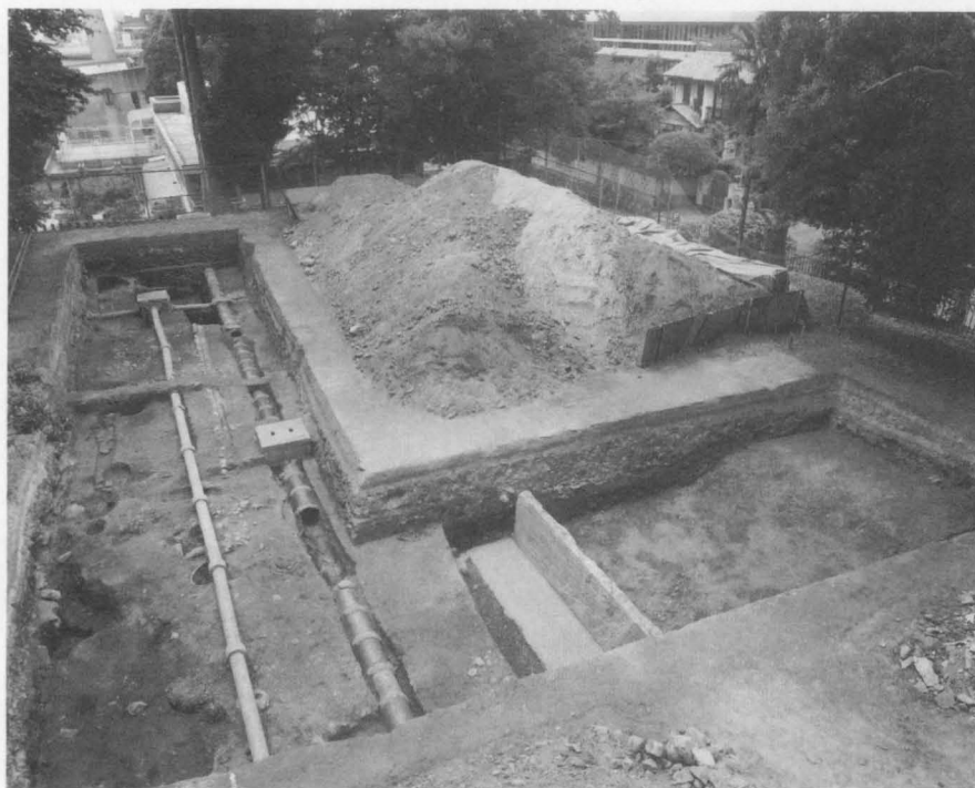
図123 調査区全景（東から）
