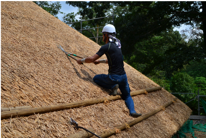
図 15 屋根鉋での上面の刈り方
