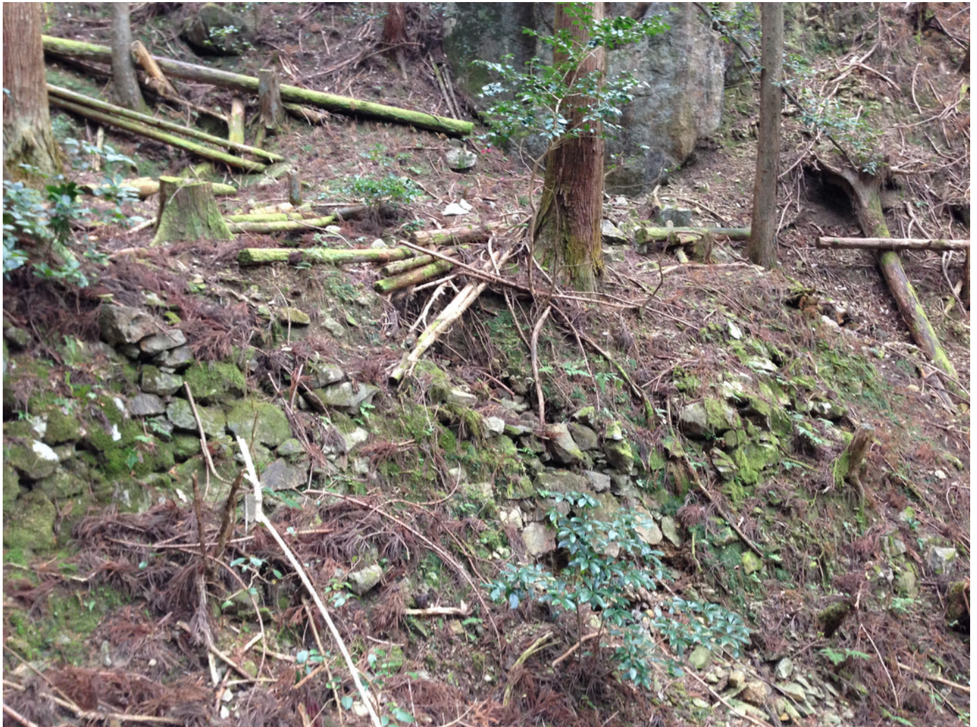
図5 谷奥部の石積平坦面
