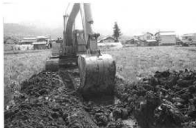
重機による試掘トレンチ
