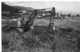
重機による試掘
