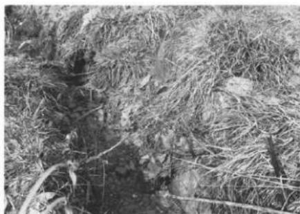
2''' しっかりした管理水路の古本沢。戦後27・8年頃、伊藤組によって流路が石積みされた。烏川の粘板岩の平石を使って、底はカメ張り、側壁は3～4段石積みの見事な流路である。
