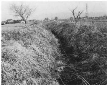
⑥ 大土手を形成して北東へ流れる芝沢（本沢）、流路は烏川の粘板岩の平石を用い、底はカメ張り、側は3～4段積み。
