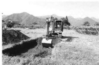
トレンチ掘削状況 (東より)
