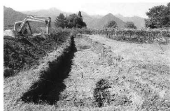
トレンチ検出状況 (東より)
