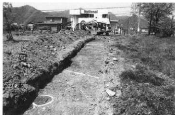
トレンチ掘削状況 (東より)
