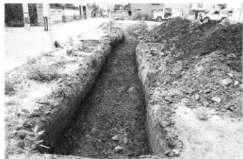
トレンチ検出状況 (北より)
