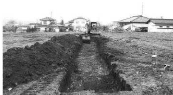
トレンチ掘削状況 (東より)
