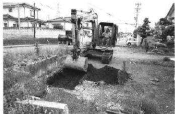
トレンチ検出状況 (東より)
