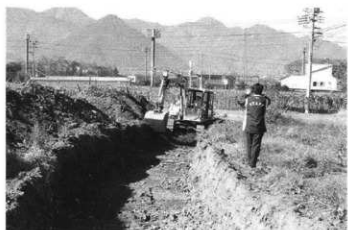
トレンチ掘削状況 (東より)
