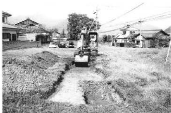
トレンチ掘削状況 (東より)
