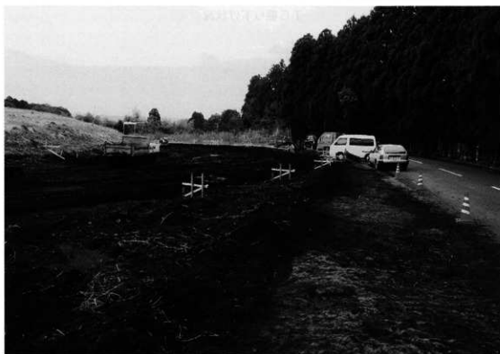
整備工事状況
