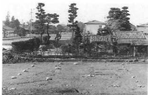
第4号礎石（東より）
