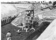
図4 排水用井戸の掘削
