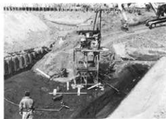
図4 排水用井戸の掘削
