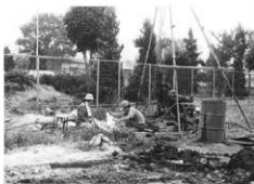
図3 ボーリング調査（⑥区中央付近）
