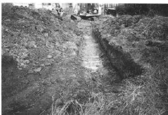
4号トレンチ検出状況 南より
