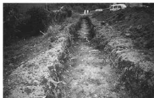
1号トレンチ検出状況 南より
