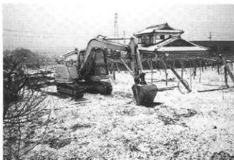
1号トレンチ掘削状況 南東より
