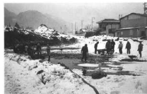
除雪・排水作業
