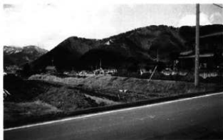
トレンチ完掘状況 南東より
