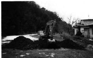
TP1掘削状況 南より
