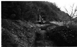
完掘状況 南より
