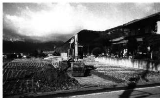
2号トレンチ掘削状況 東より
