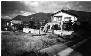
1号トレンチ掘削状況 南東より
