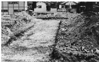
校舍基礎 掘削
