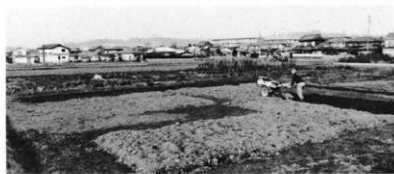
埋土均し作業
