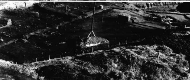
3. 同上(北西より)
