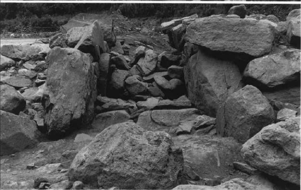
第24号墳溪道閉塞状況 開口方向より
