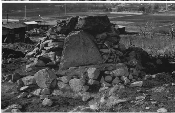
第23号墳石室裏込め除去後 東より
