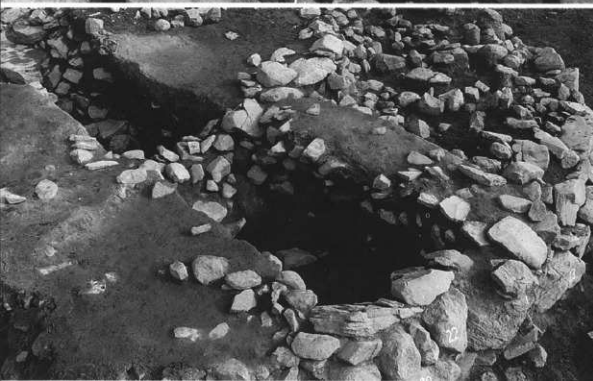
第23号墳Dトレンチ付近裾石 および内回り石組 西より
