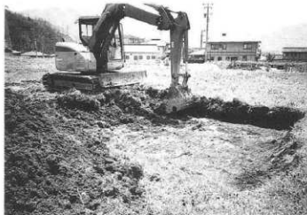
1号トレンチ検出状況 (北東より)
