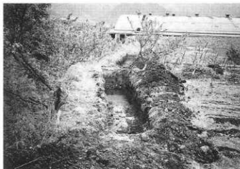
1・2号トレンチ完掘状況(東より)
