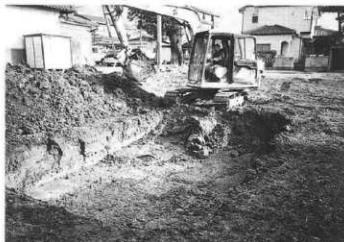
トレンチ掘削状況 (西より)
