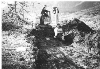
2号トレンチ掘削状況 (東より)
