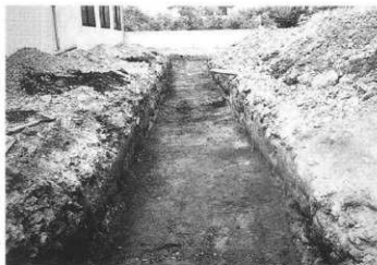
トレンチ検出状況 (南より)
