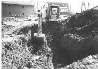
トレンチ掘削状況（北より）
