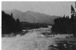
6. 工事のすすむ大徳原北遺跡
