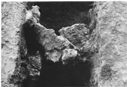
同、炉底内部（炉壁やスラグがつめられている）
