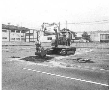
重機による掘り下げ
