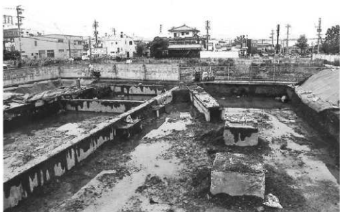
調査地湧水状態（東から）
