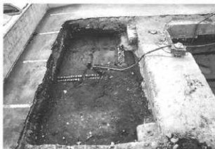
南側部分完掘 (東から)
