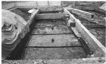
中央部分完掘 (東から)
