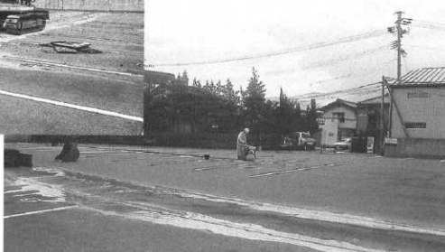
コンクリートカッターによる アスファルト舗装切断
