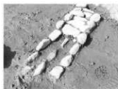
③暗渠部分両端に平行して小礫を列状に2列並べさらに中央にもう1列礫列を配置して両端礫間に平な石を蓋石として渡すもの(暗渠22)
