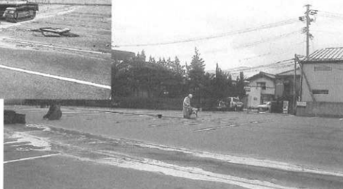
コンクリートカッターによる アスファルト舗装切断
