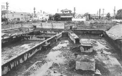
調査地湧水状態（東から）
