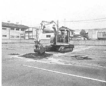
重機による掘り下げ
