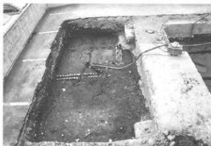
南側部分完掘 (東から)
