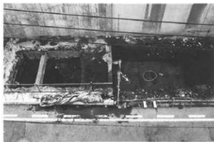
本町第2次・2検 全景
