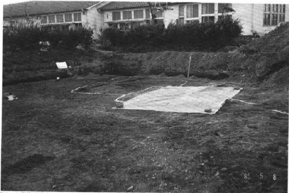
第1・2号住居址掘り下げ中(東より)
