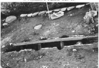
竹管の構造（懸手で支え、上板で保護されている）
