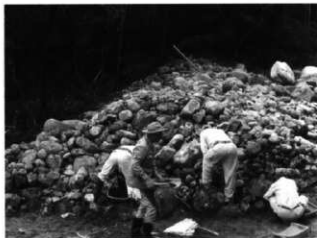
H11年度 乳川石堤 作業風景
