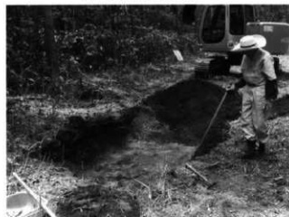
H12年度寺海戸遺跡 試掘トレンチ掘削
