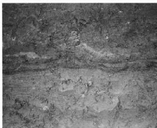
左：第4水田 畦畔断面 右：第3水田 と第4水田 大畦畔の断面
