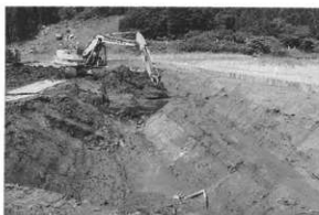
重機によるトレンチの掘削（A3地区）
