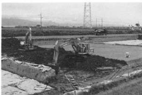
重機による刈ぎ（D2地区）
