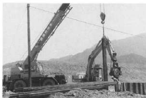
止水鋼矢板の打設（B2地区）
