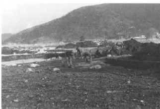
作業風景 (南から)
