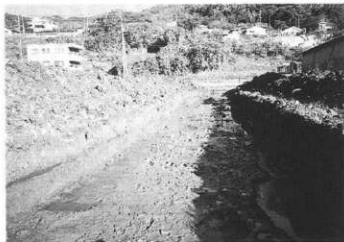
トレンチ検出状況 (西より)
