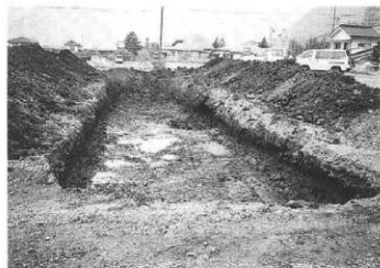
2号トレンチ作業状況 (東より)
