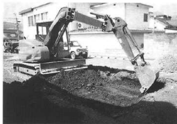
トレンチ掘削状況 (東より)
