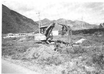
トレンチ掘削状況 (南東より)
