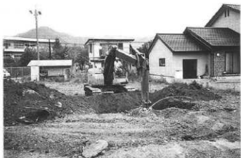
1号トレンチ掘削状況 (東より)
