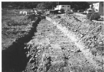
1号トレンチ掘削状況 (東より)
