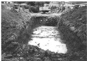
1号トレンチ検出状況 (西より)
