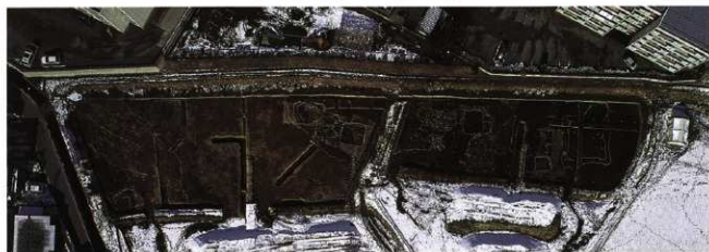
A地区北西・北東全景（南から）
