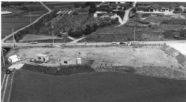
平成11年度調査 部分(南東から)
