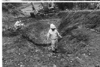
左：固化作業 右：周溝完掘 （西より）
