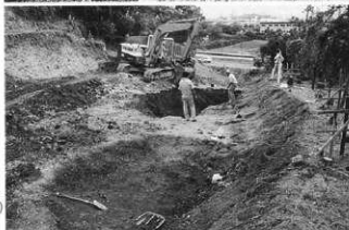
左：作業風景 （西より） 右：西側周溝遺物、石組 （西より）
