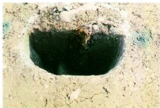
P163 (建物の柱痕。穴の底には、基礎石が敷いてある)
