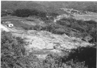
II次調査区、西から
