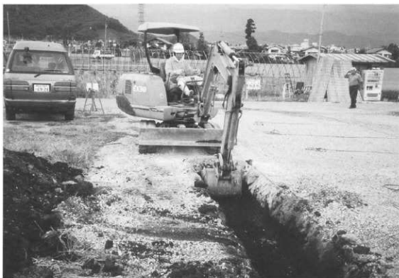
重機による除去作業
