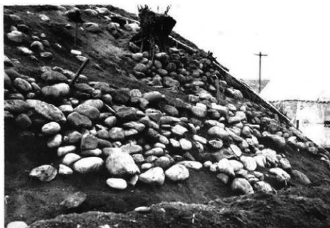
西側の葦石の一部
