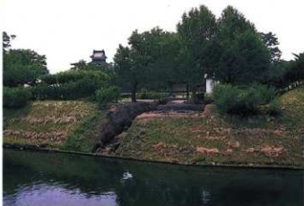
トレンチ7 遠景（北東から）
