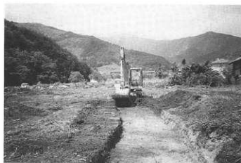
トレンチ掘削状況(東より)
