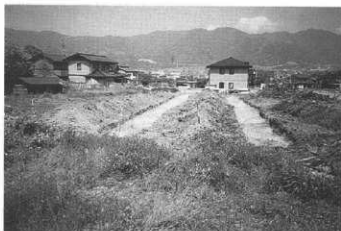
トレンチ完掘状況(西より)
