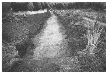
16号トレンチ完掘状況(北西より)
