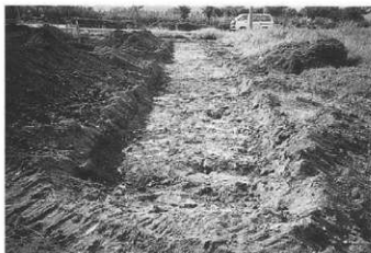
2号トレンチ完掘状況(北より)
