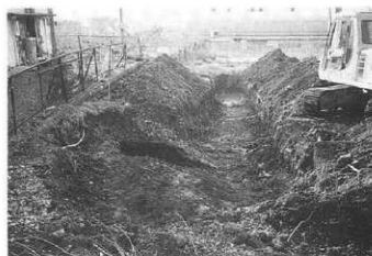
2号トレンチ完掘状況(東より)
