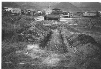
4号トレンチ完掘状況(東より)
