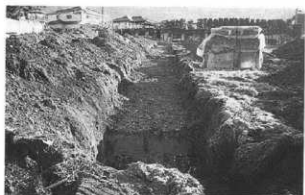
2号トレンチ完掘状況(西より)
