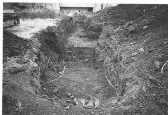
1号トレンチ完掘状況(北より)
