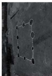
ST 14の全景（白線入り）
