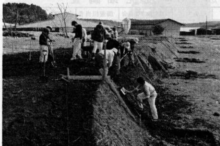
外堤復元工事作業状況
