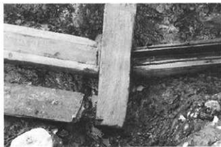
木樋上蓋（左）と中蓋（右）を取りはずし後
