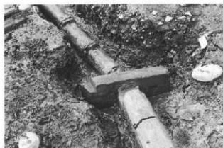
木樋ジョイント部
