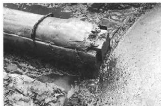
栓のある木樋（埋設桶8の接合部）
