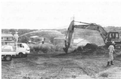
ほこりじめしのための散水作業 また、遺構面への散水も行った。
